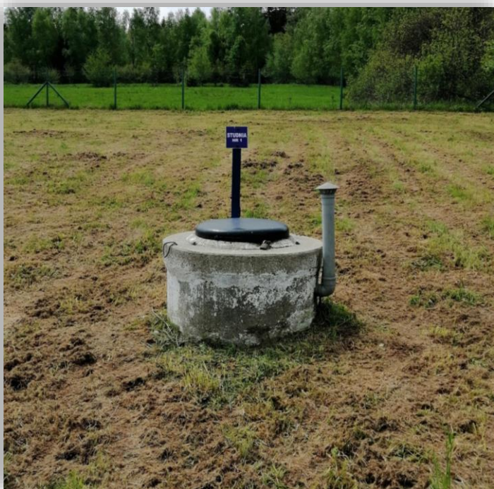
jedna ze studni drenażowych
