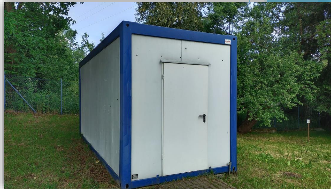
stacja uzdatniania wody
