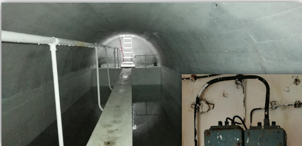
wnętrze zbiornika końcowego po renowacji
