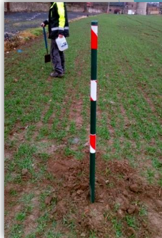
lokalizacja jednej z komór wodociągowych oczekującej na odkopanie
