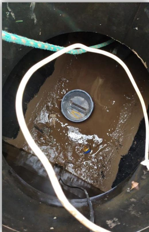
zbiornik buforowy w trakcie czyszczenia
