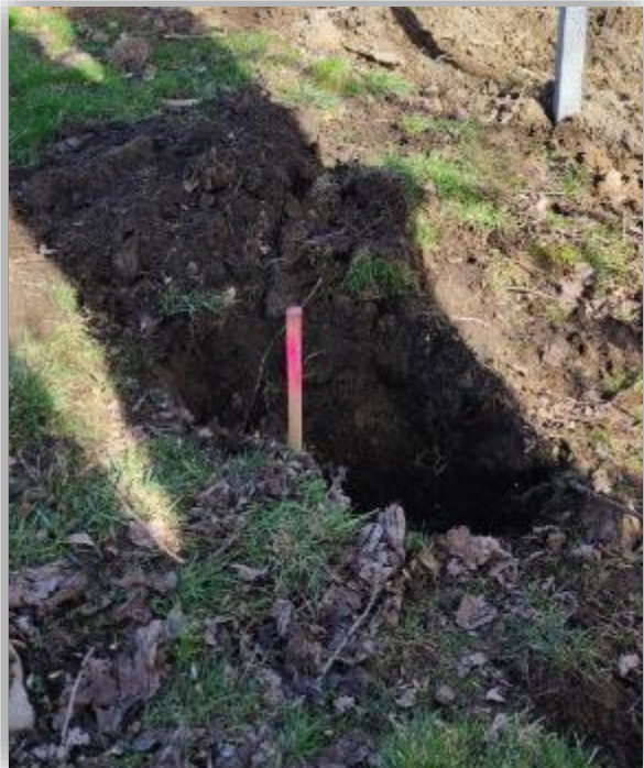
komora wodociągowa przed i po odkopaniu
