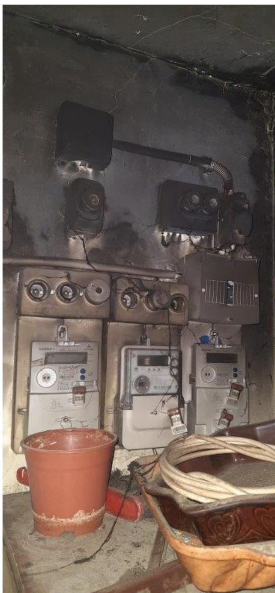
Budynek przed remontem
