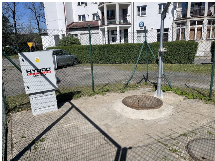
Przepompownia przy ul. Pocztovej po modernizacji
