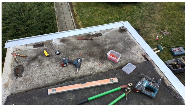
Remont dachu budynku socjalnego na terenie oczyszczalni ścieków
