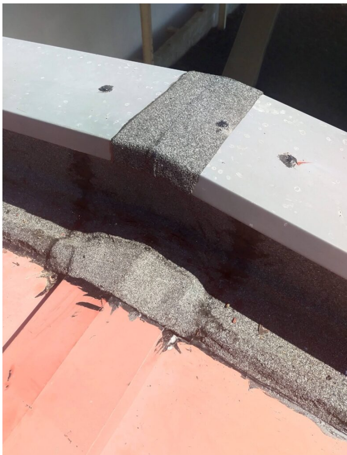
Doszczelnienie dachu budynku prasy na terenie oczyszczalni ścieków
