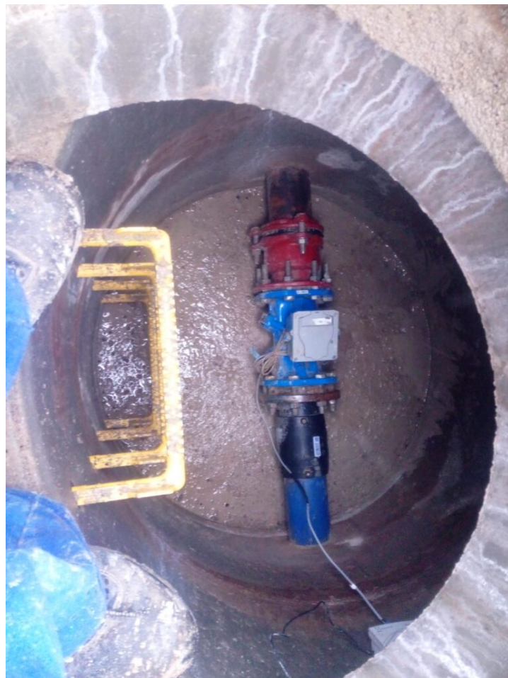
wodomierz strefowy "Baworowo" po zamontowaniu
