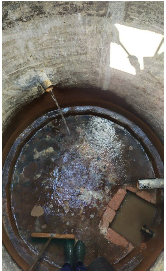
zbiornik na ujęciu w Szyszkowej po oczyszczeniu
