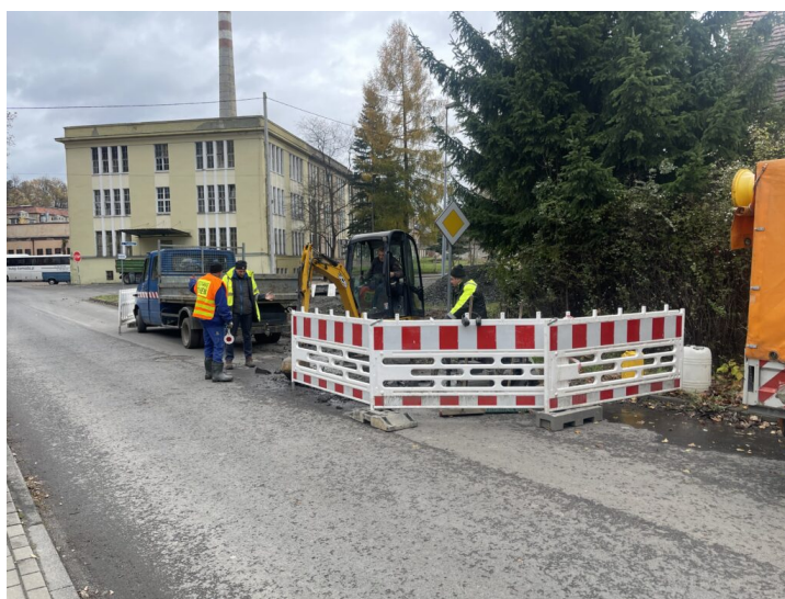
usuwanie awarii na sieci wodociągowej w okolicy ul. Orzeszkowej 18 w Leśnej – listopad 2023 r.
