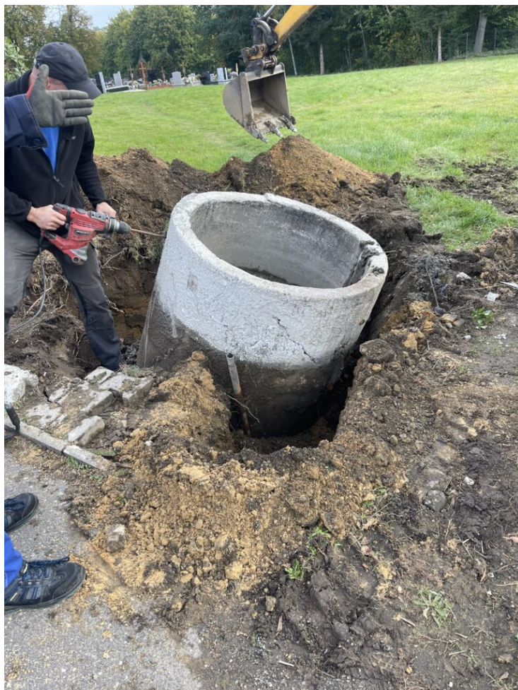
Rozbiórka starego punktu poboru wody na terenie cmentarza komunalnego w Leśnej (październik 2023)
