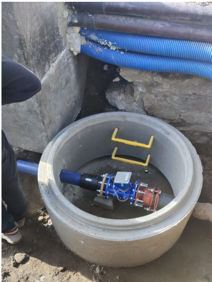
wodomierz strefowy "Baworowo" w trakcie montażu
