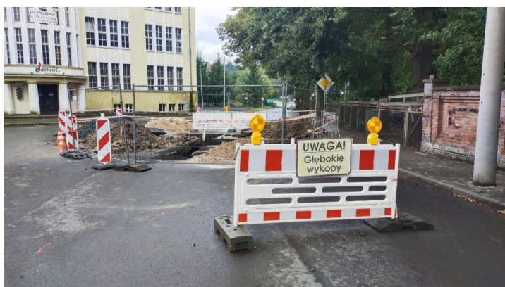
usuwanie awarii na sieci wodociągowej w rejonie byłych zakładów "Dolwis" – wrzesień 2023 r.
