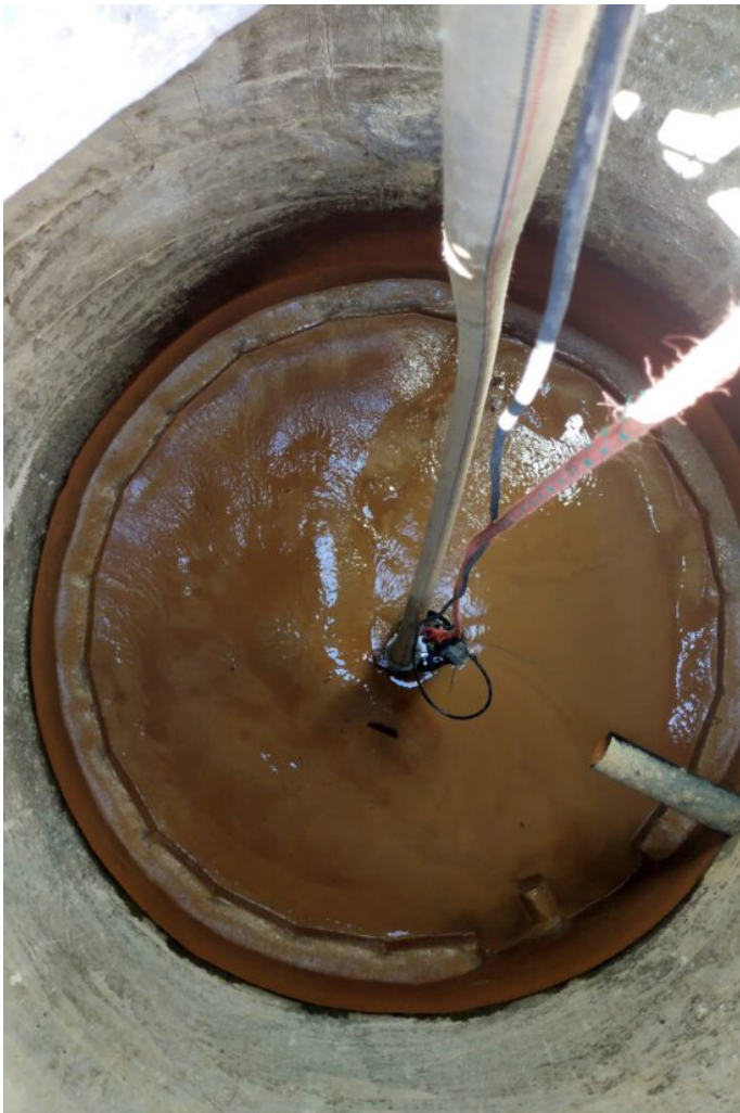
zbiornik na ujęciu w Szyszkowej przed czyszczeniem
