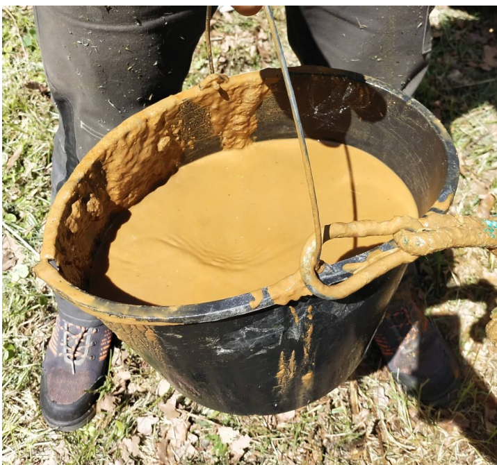
W trakcie prac oczyszczających na ujęciu w Szyszkowej
